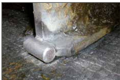
pattini laterali con largo appoggio e ferro tondo aggiunto
