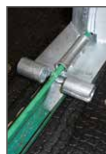
ampio appoggio per il blocco centrale e con ferri tondi aggiunti
